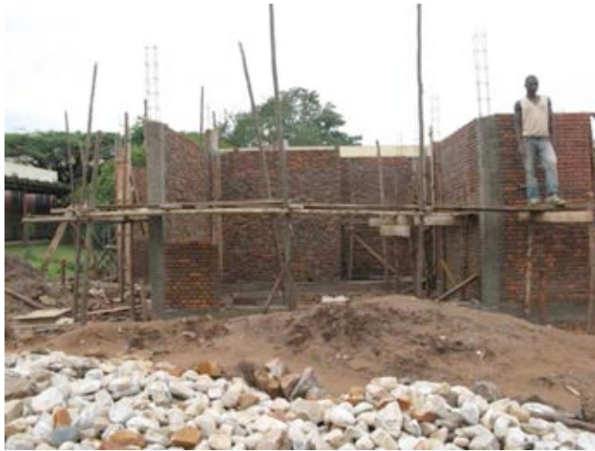
Photo 5 : travaux du bloc de PTME du CHUK, à gauche la zone d'attente pour les consultations de CPN et de Planning Familial
