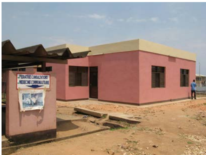
Photo 3 : Bâtiment de PTME du CHUK le 19/08/2014
